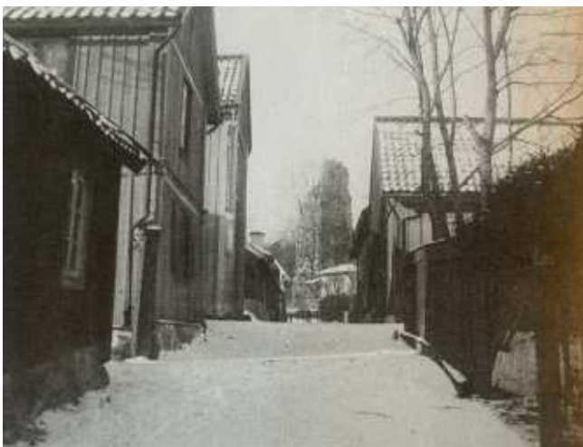
Laurentii gränd fotograferad från söder mot norr. Kvarteret Brasan skymtar till vänster strax innan ruinen. De borte byggnaderna tycks vara lägre än dagens. Foto: Arvid Drake, år okänt. Källa: Sigtuna Bilder, 2006.
